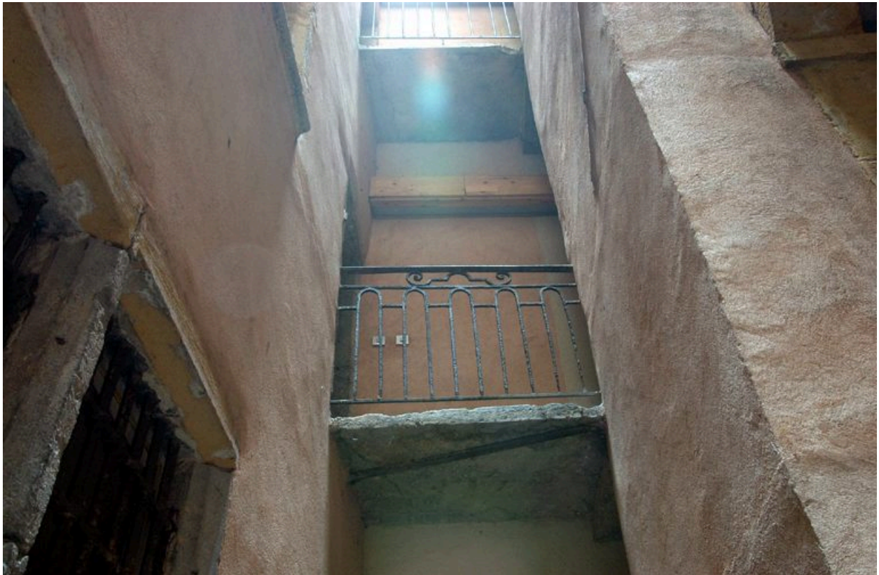
Coursière, côté nord de la cour
