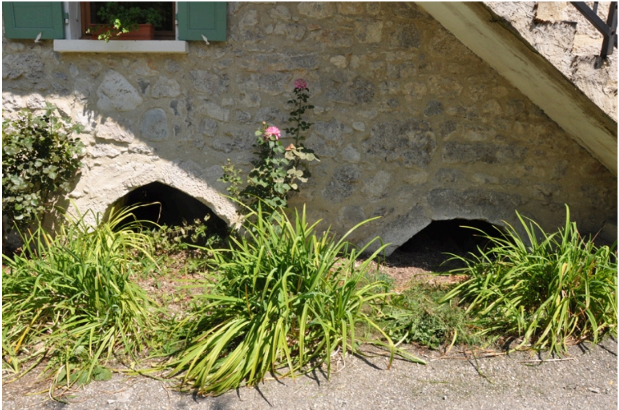
Détail des arcs brisés du moulin amont
