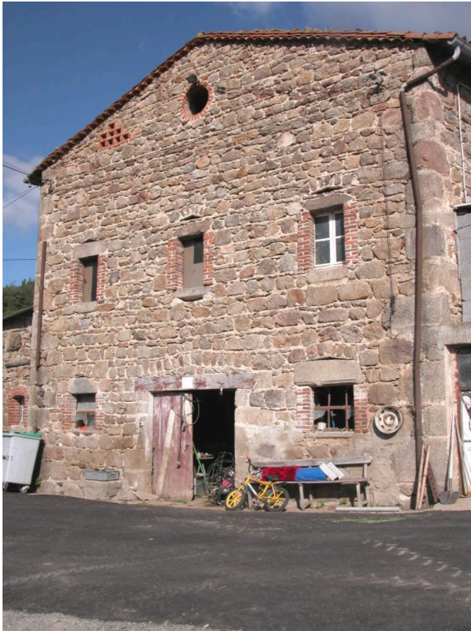
Vue d'ensemble du mur pignon sud de la grange-étable.
