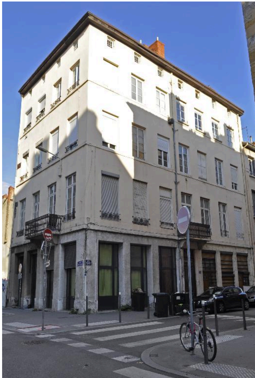
Vue d'ensemble depuis la rue Chalopin
