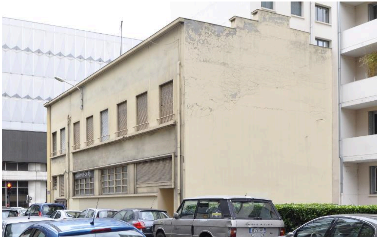
Vue sur les façades nord et est
