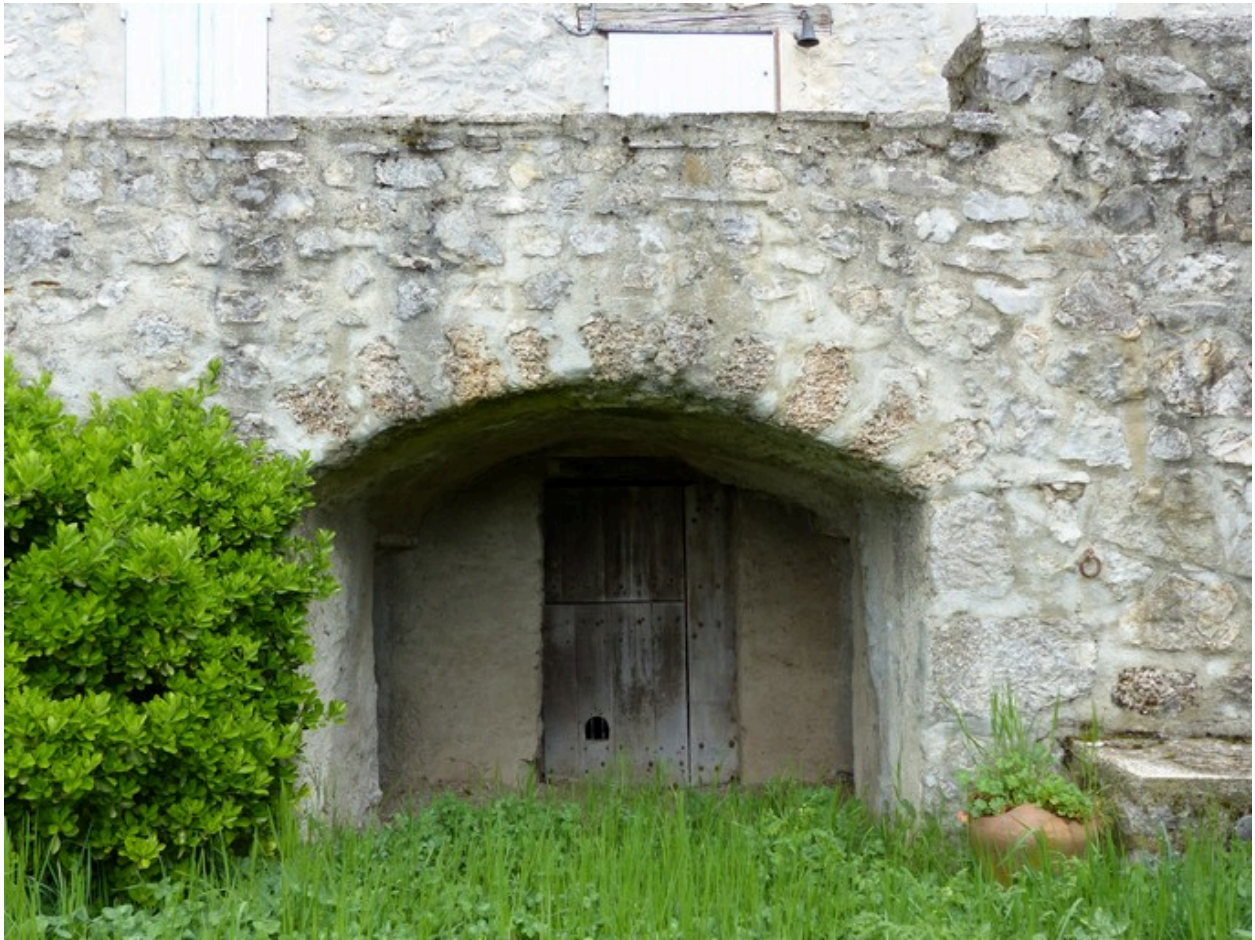
Palier filant extérieur, sur voûte en berceau segmentaire. Ferme à proximité du village.
