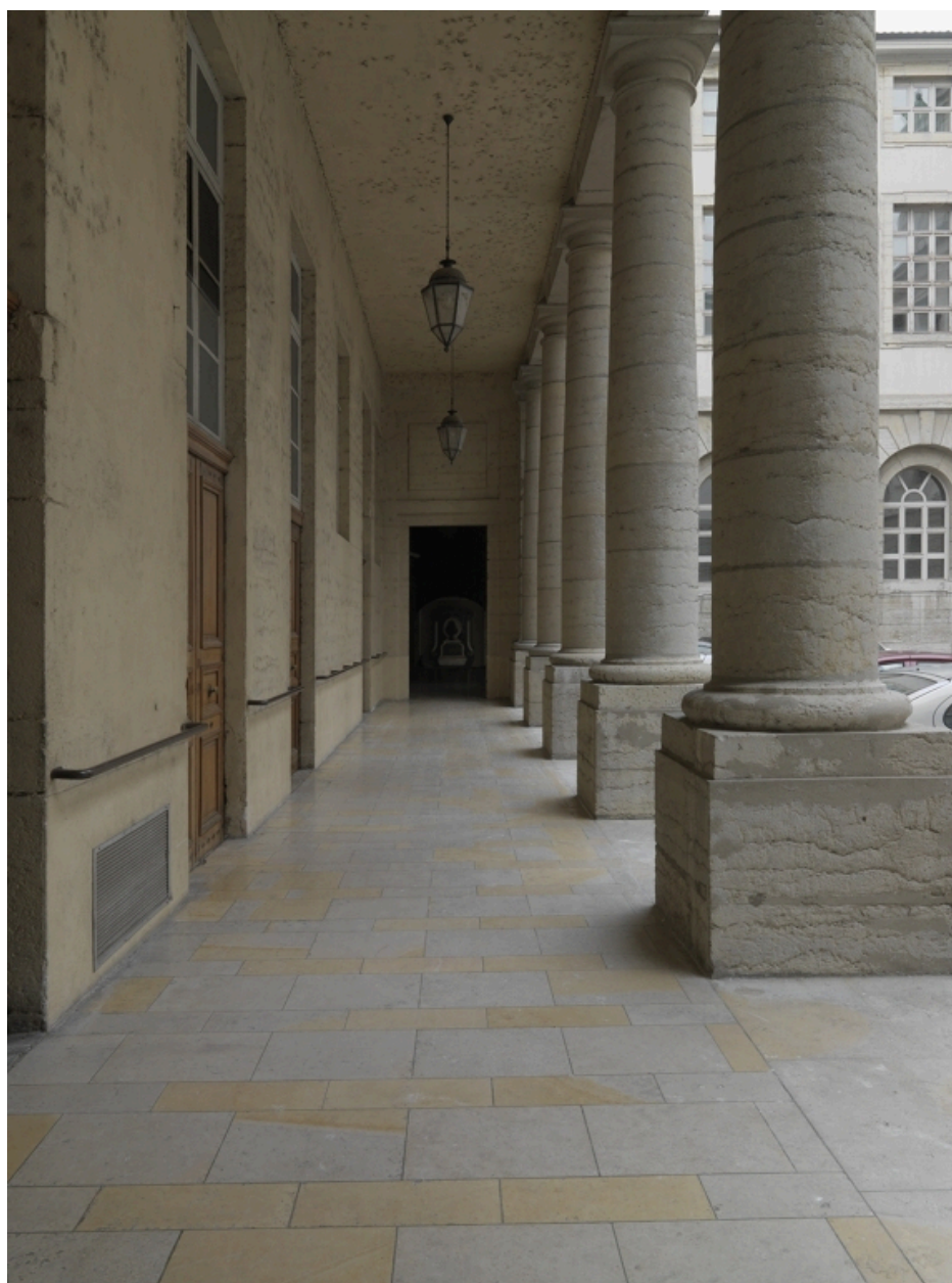
Bâtiment I. La colonnade à l'ouest de la cour de la cuisine
