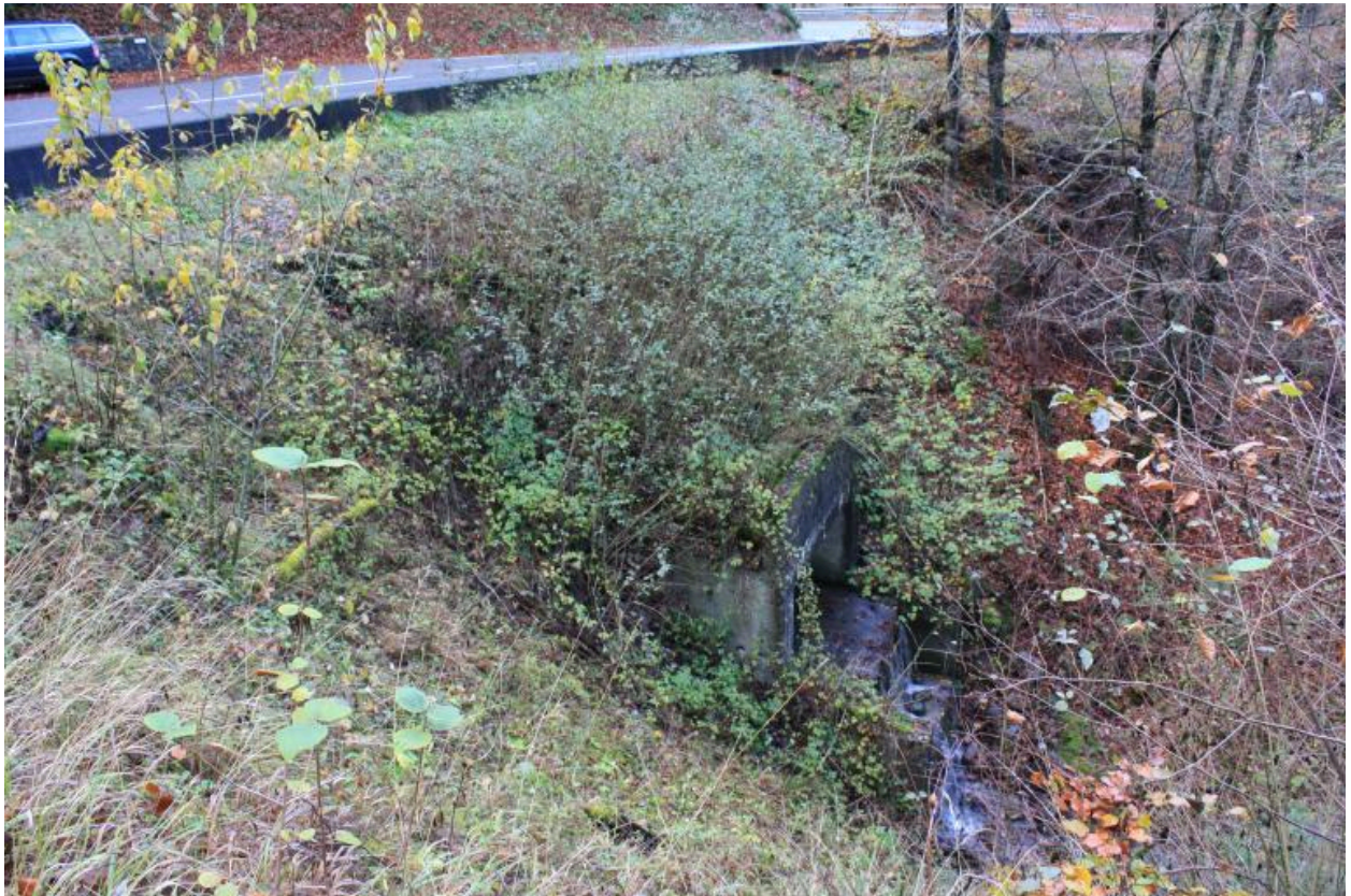
Pont de Trélachaud, face en aval
