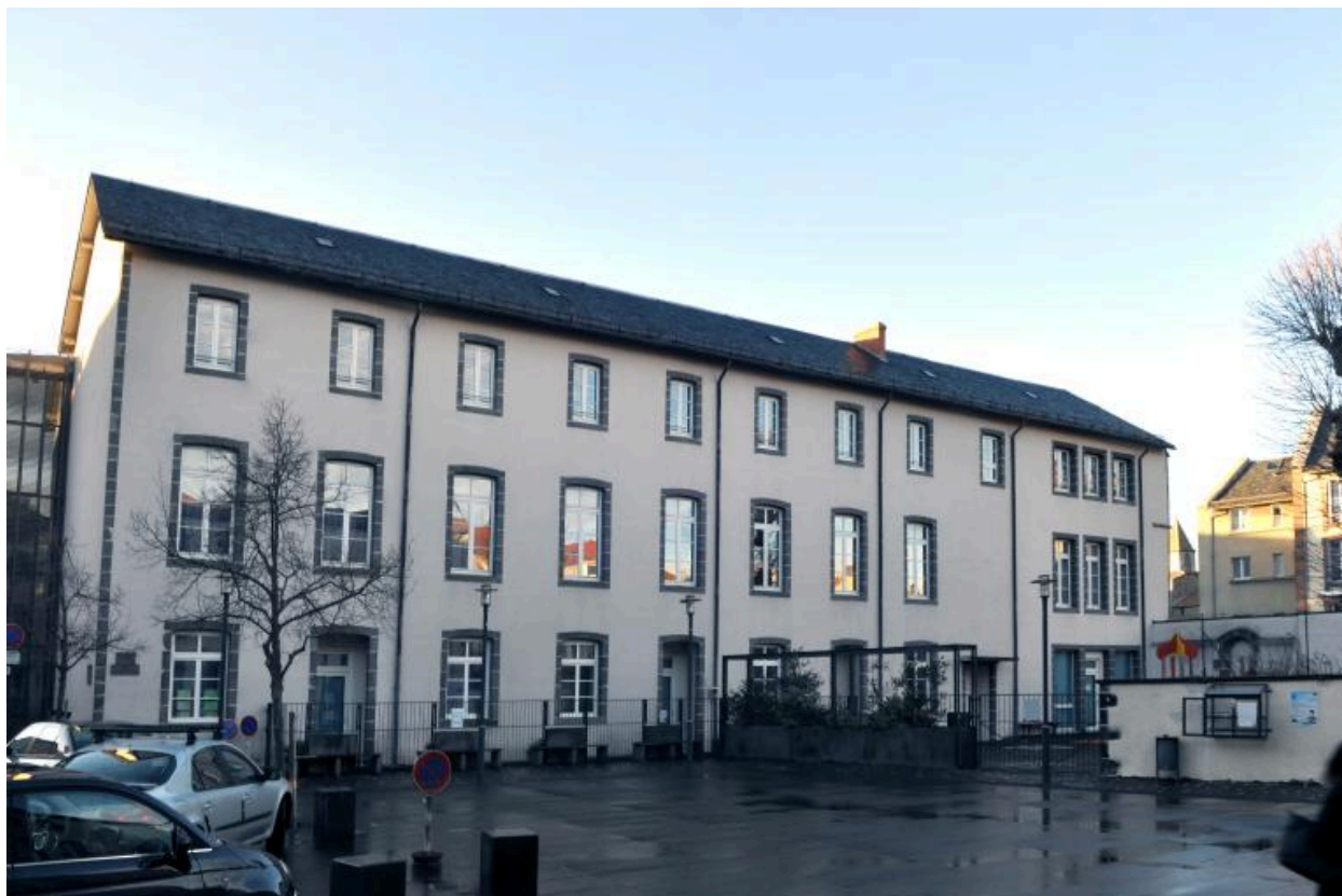
Corps de bâtiment est : vue d'ensemble depuis l'est
