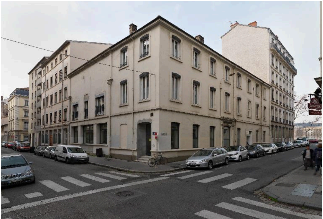
Vue d'ensemble, depuis la rue Cavenne
