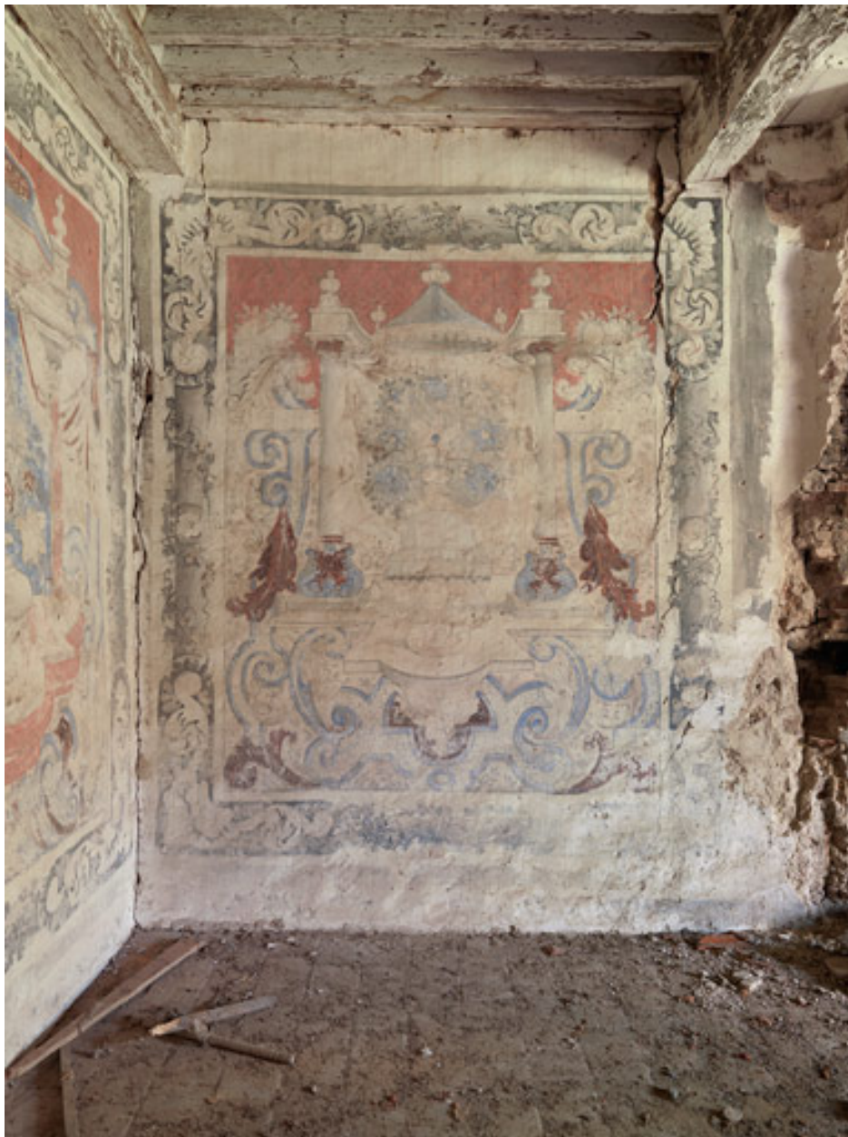
Mur sud, panneau à gauche de la cheminée.
