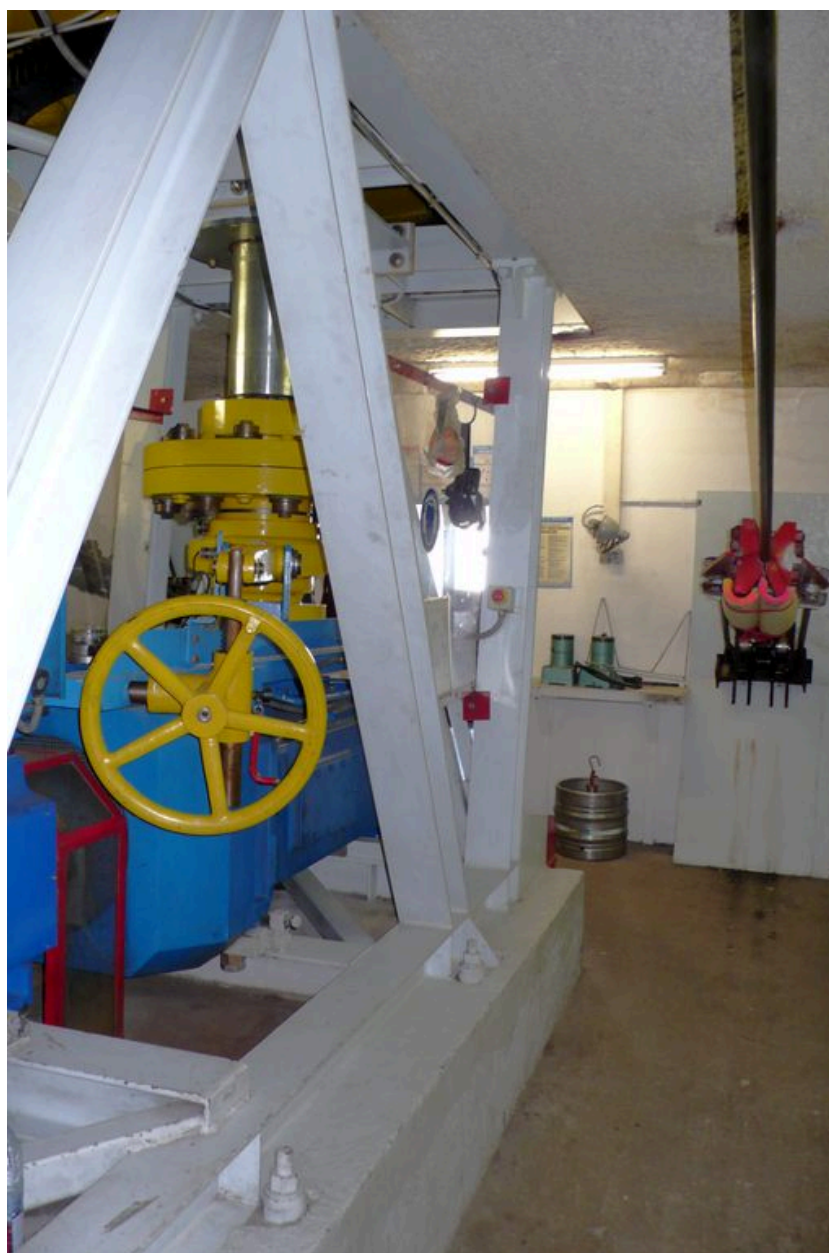
Gare inférieure. Le mécanisme
