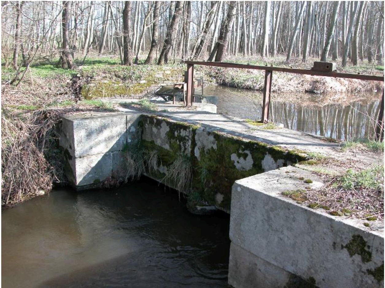
Vue d'ensemble aval de la prise d'eau du bief.
