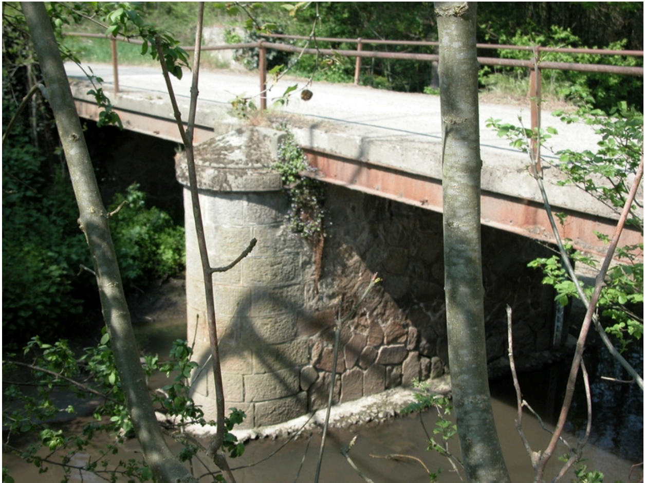
Vue du pont sur le Vizézy à Bullieu (1986 F non cadastré, vers F 17).
