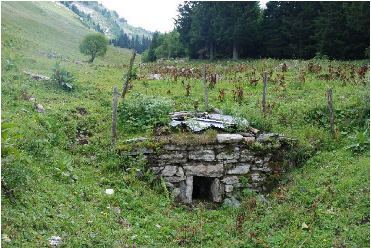
Prise d'eau aux Arbets (alpage de l'Arclusaz) : vue extérieure de l'entrée.
