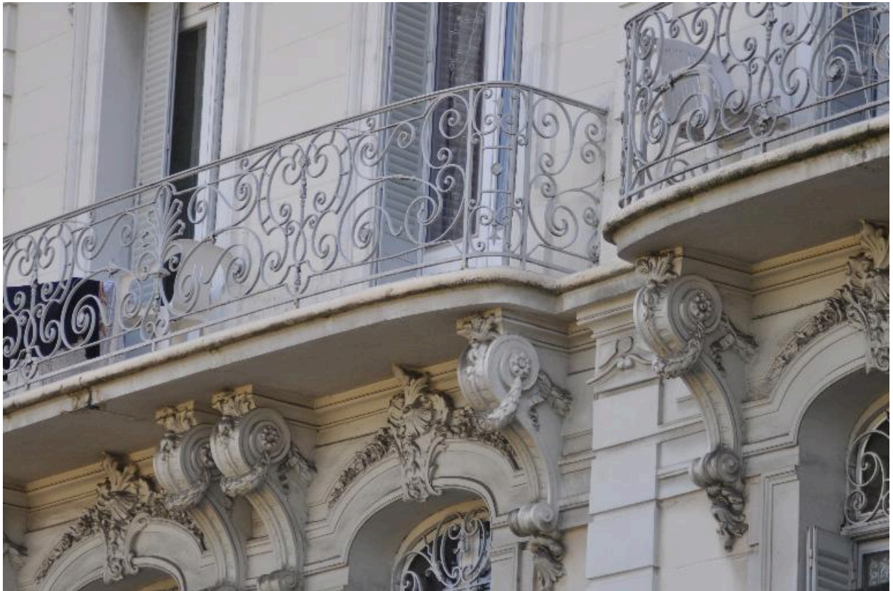
Détail des consoles des balcons du 2nd étage
