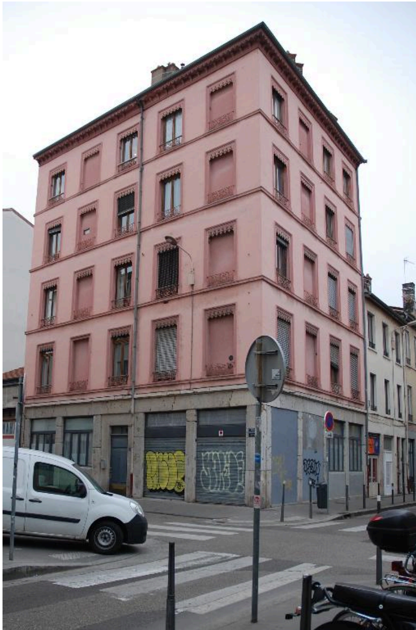
Vue oblique, depuis l'est
