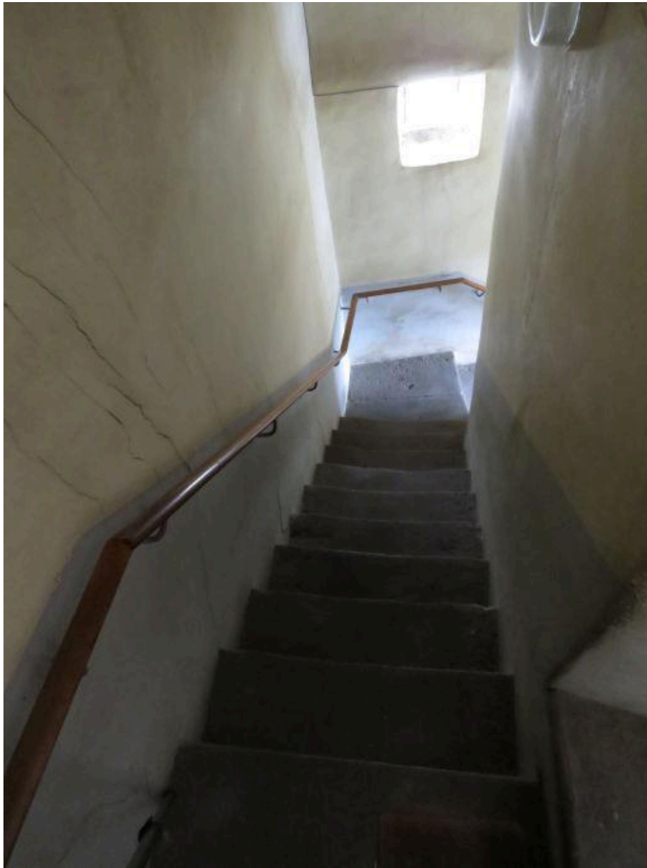
Vue intérieure : escalier
