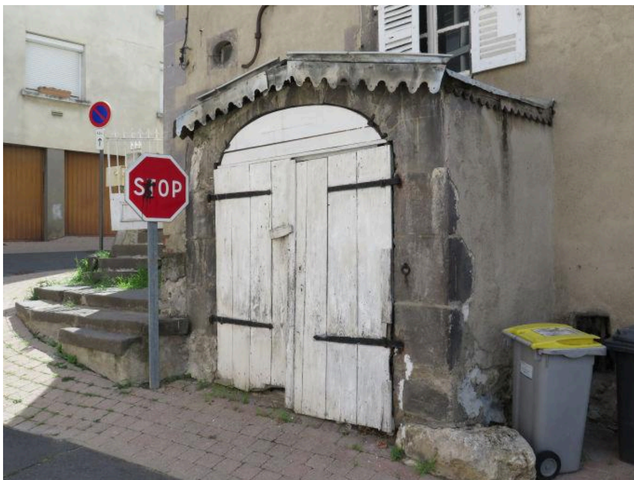
Descente de cave formant corps de bâtiment : Lempdes, 2 rue Notre-Dame
