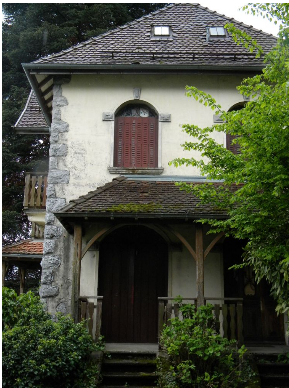
Vue du pignon nord avec le perron couvert.
