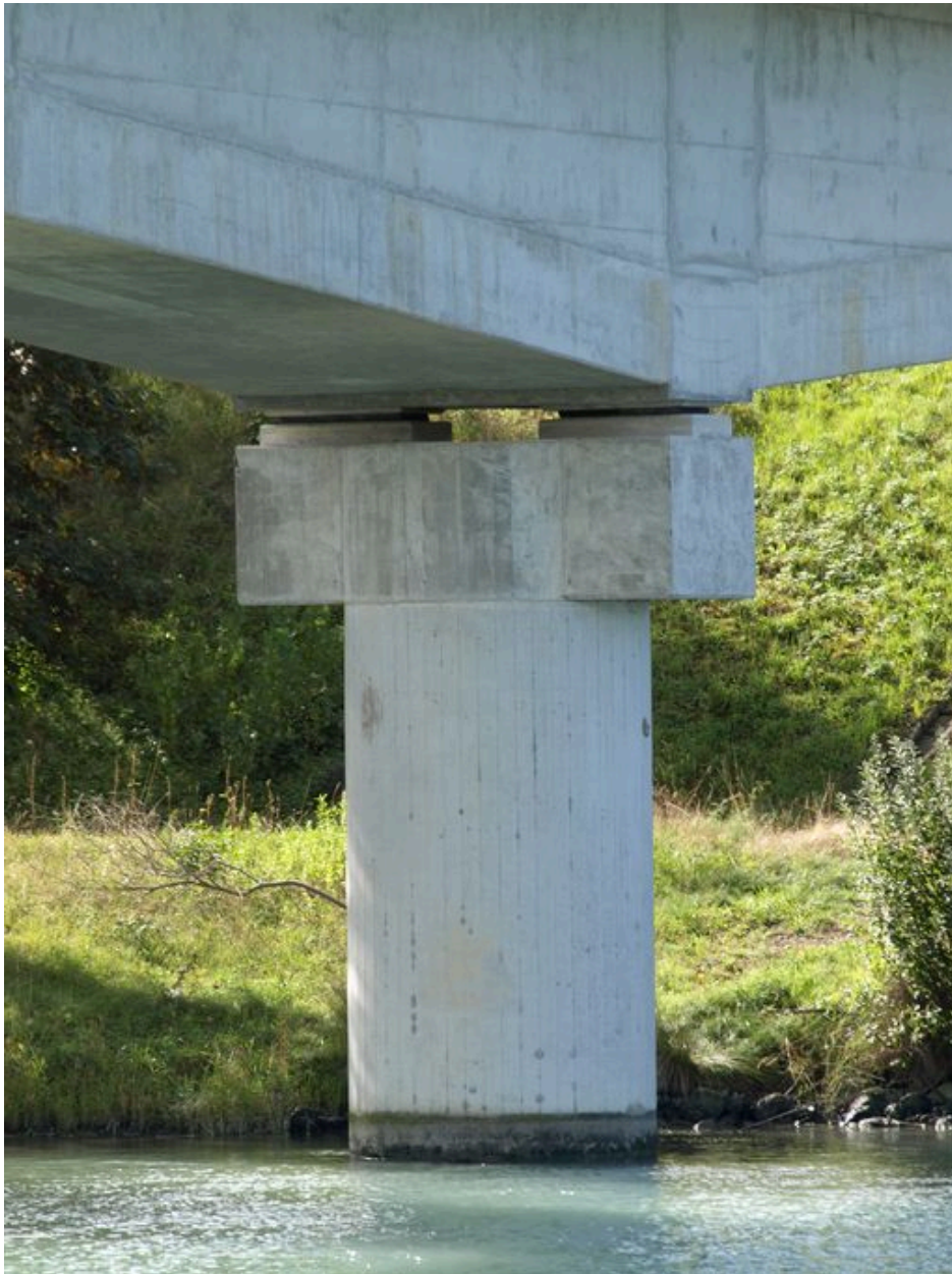
Pile, face aval (depuis la rive droite)
