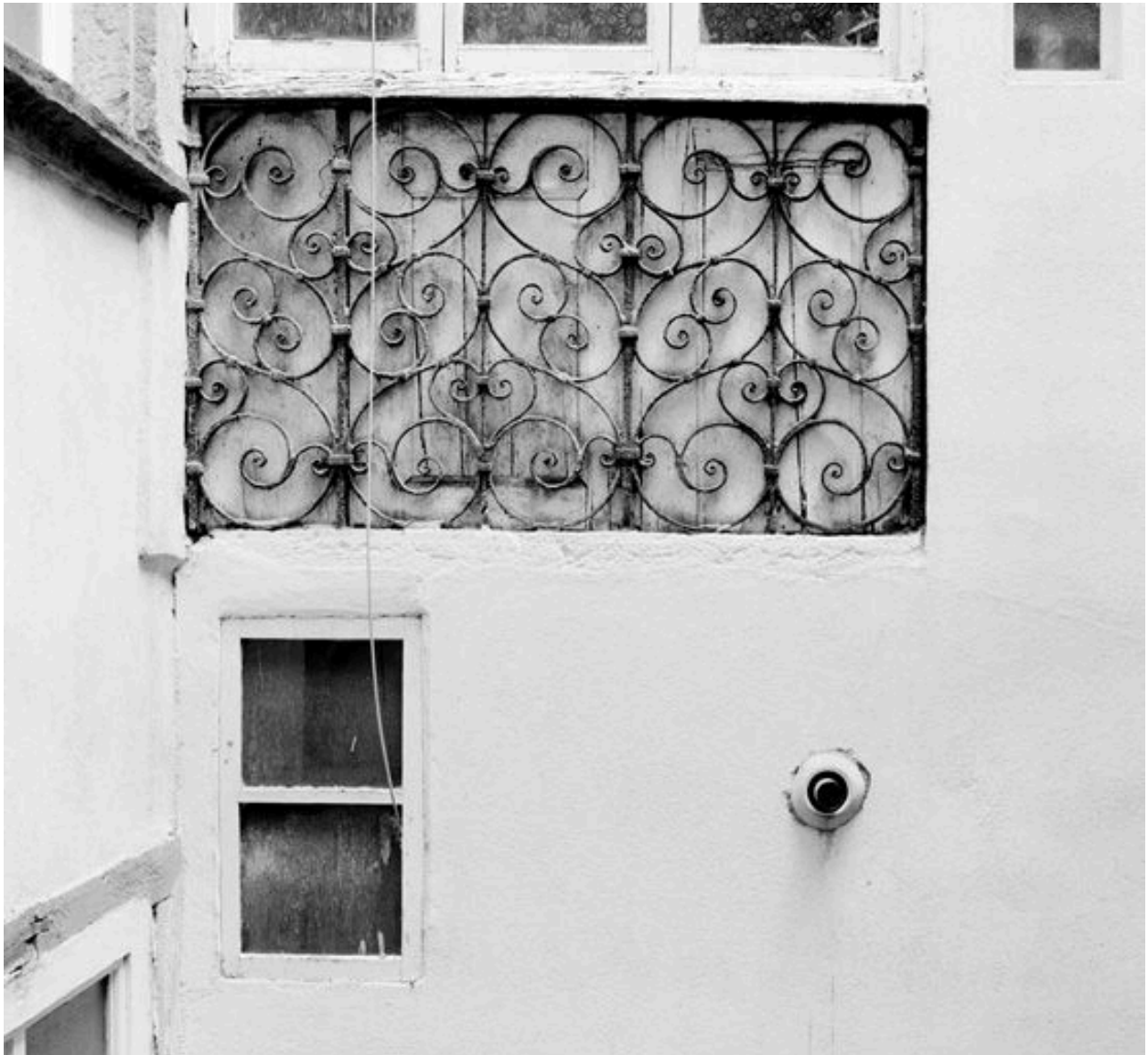
Anciennes coursières en fond de cour, détail du garde-corps du 4e niveau
