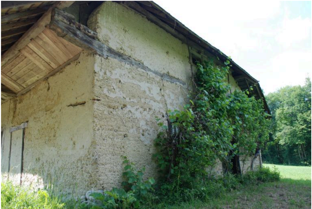
Vue de l'angle sud-est.
