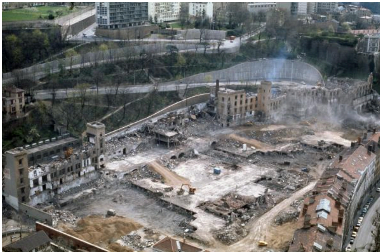
Vue de l'usine Gillet en démolition 1977 (BM Lyon (BM Lyon - CRDP de Lyon)
