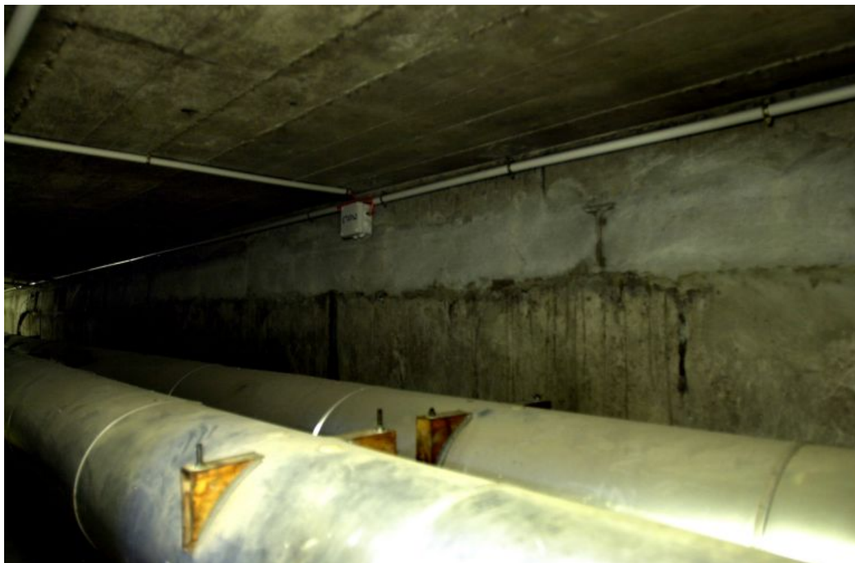
Sous-sol : détail du calage de la piste en béton armé
