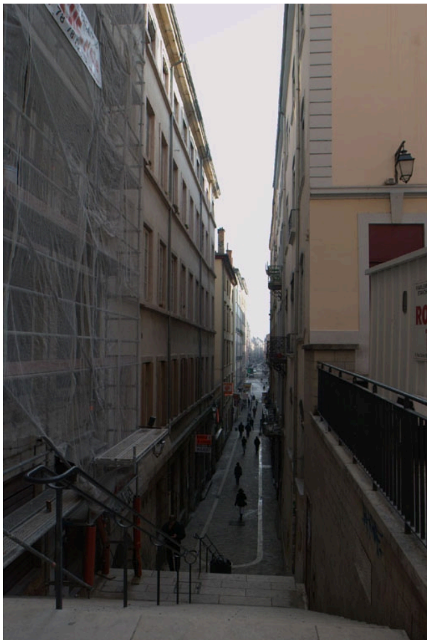
Vue nord de l'immeuble XVIIIe de la rue Sainte-Marie-des-Terreux
