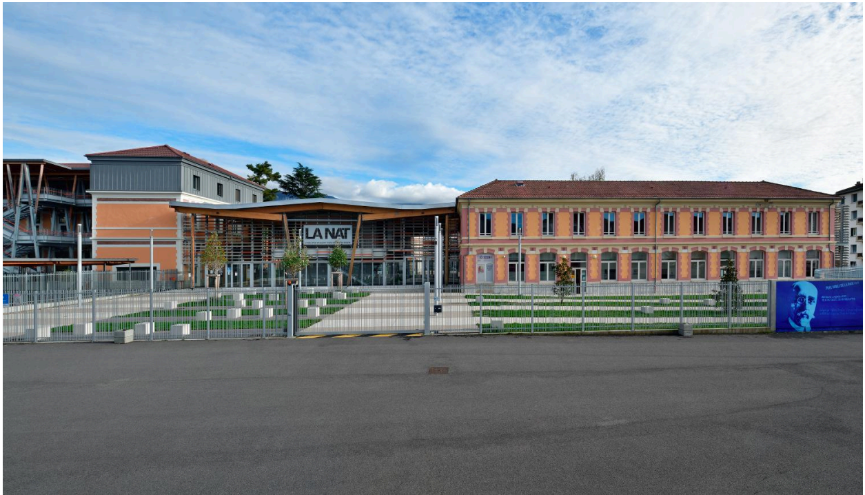
Vue d'ensemble et entrée principale
