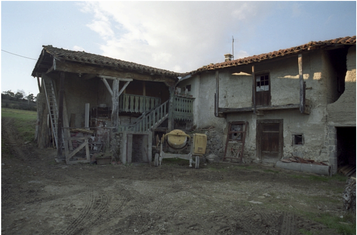
Vue d'ensemble depuis la cour, au sud-est.
