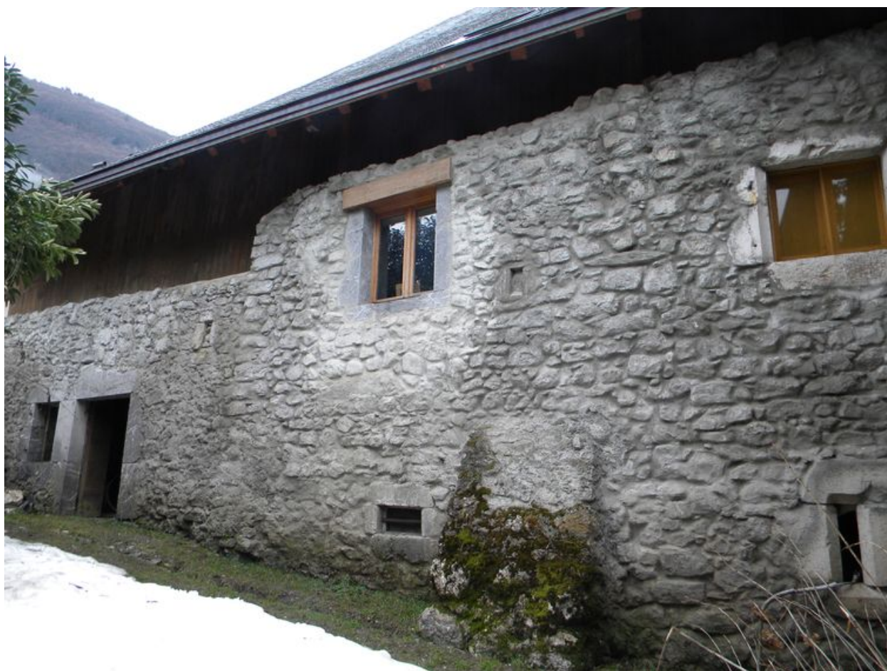
Vue de la façade arrière.
