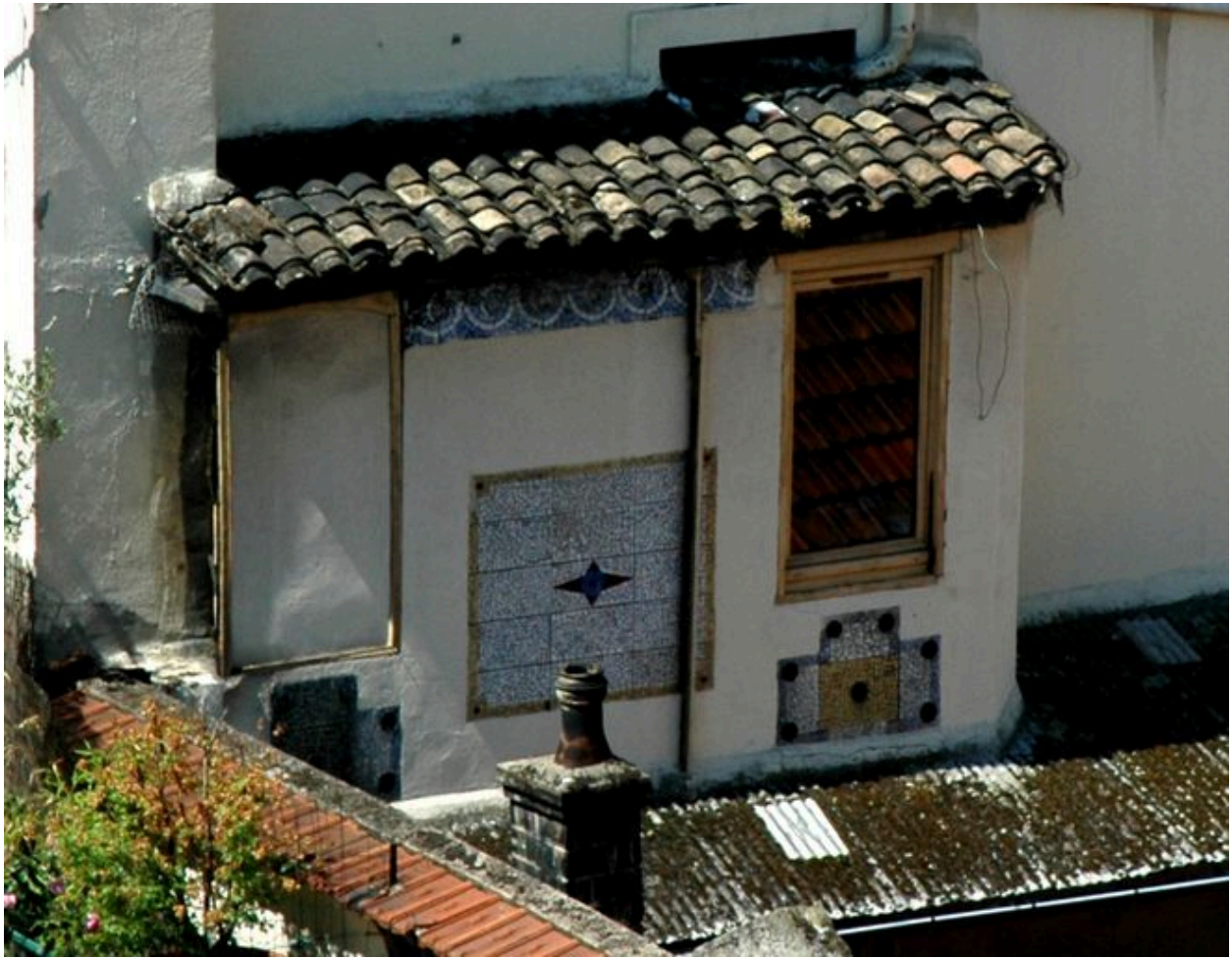
Vestiges du décor de l'établissement de bains, pignon nord
