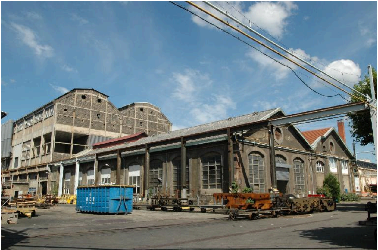
Vue extérieure des ateliers
