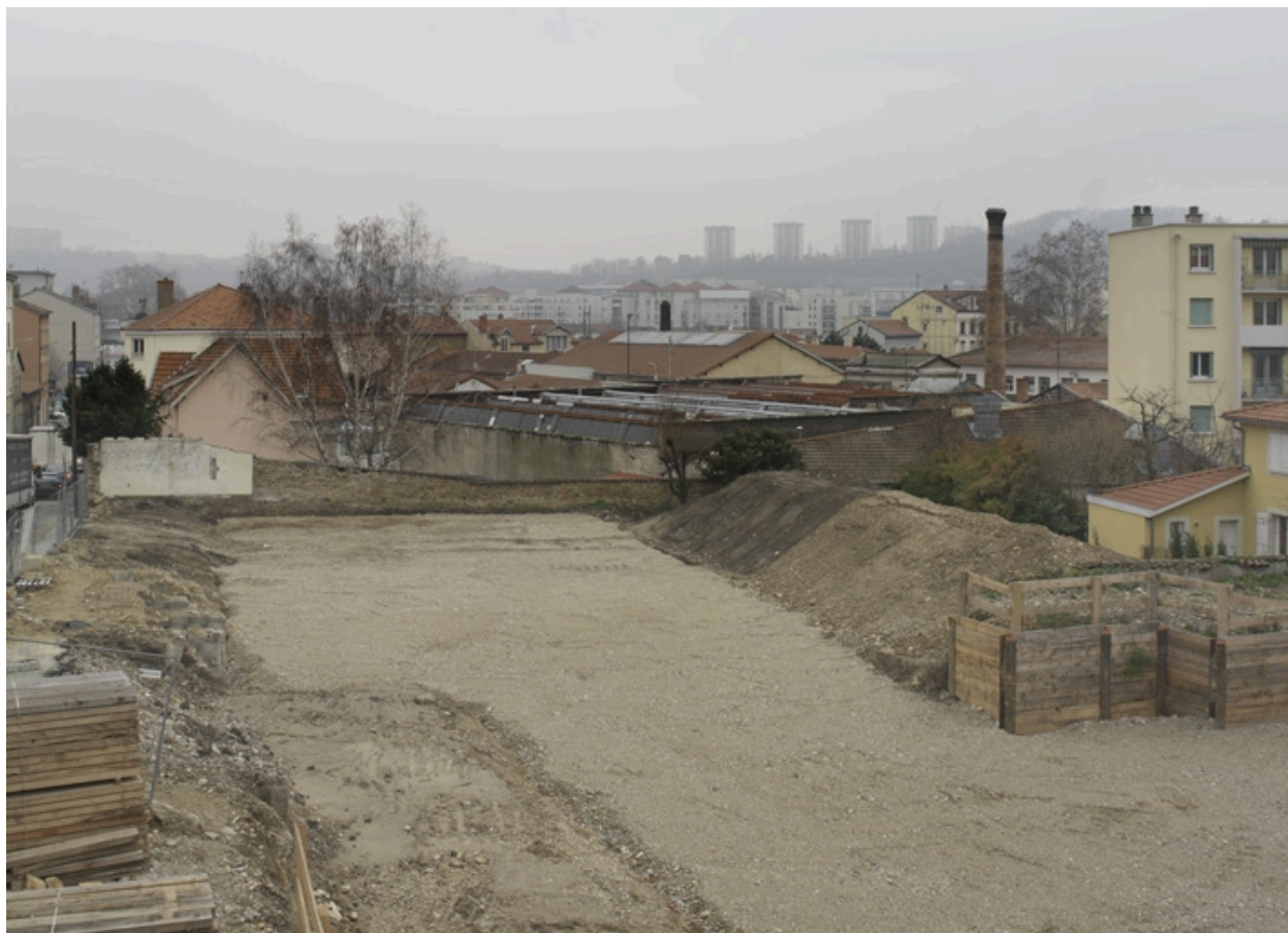
Vue nord-ouest du site (toit shed)
