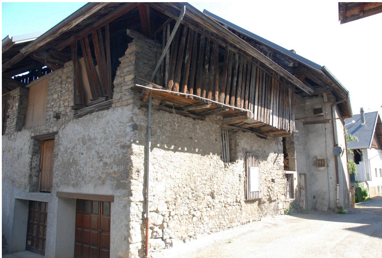
Dépendance avec extensions du fenil en charpente (2018 D3 734).
