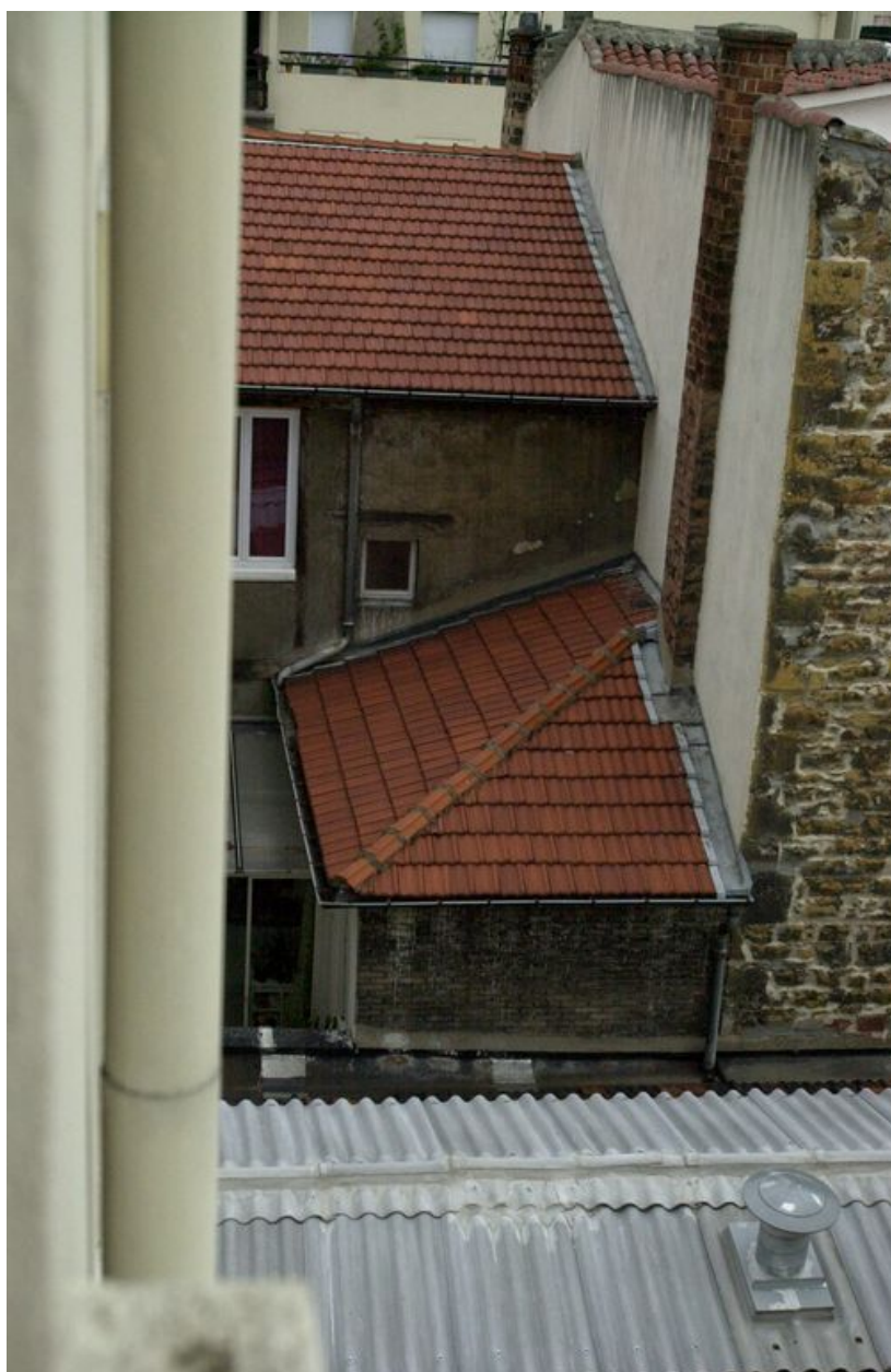
Elévation postérieure et corps de bâtiment en retour à l'arrière
