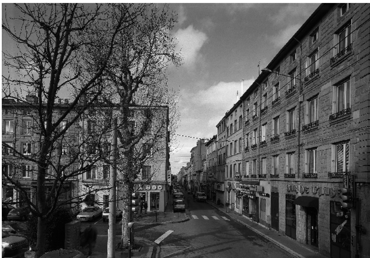
Façades des immeubles de passementiers le long de la rue Antoine-Durafour ; à gauche, la place Saint-Roch
