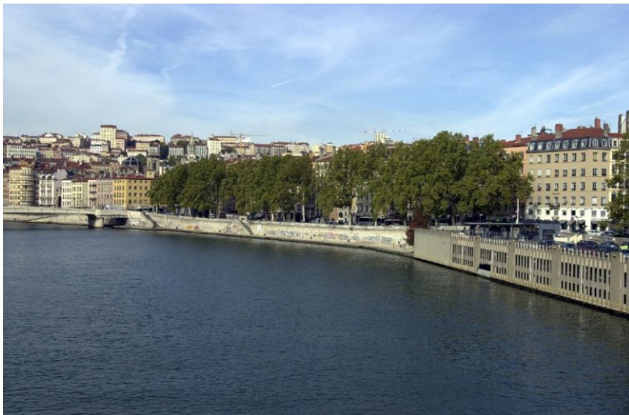
Vue générale depuis le pont Alphonse-Juin
