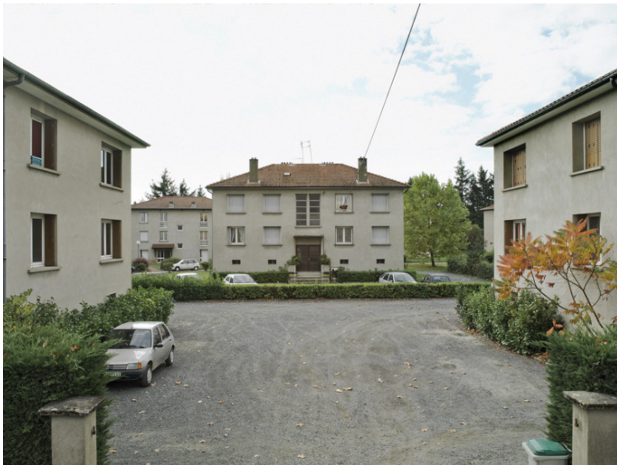
Vue d'ensemble du bâtiment n° 3.
