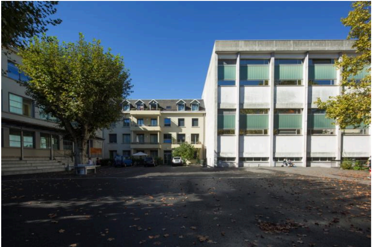
Gymnase. Façade sur la cour.
