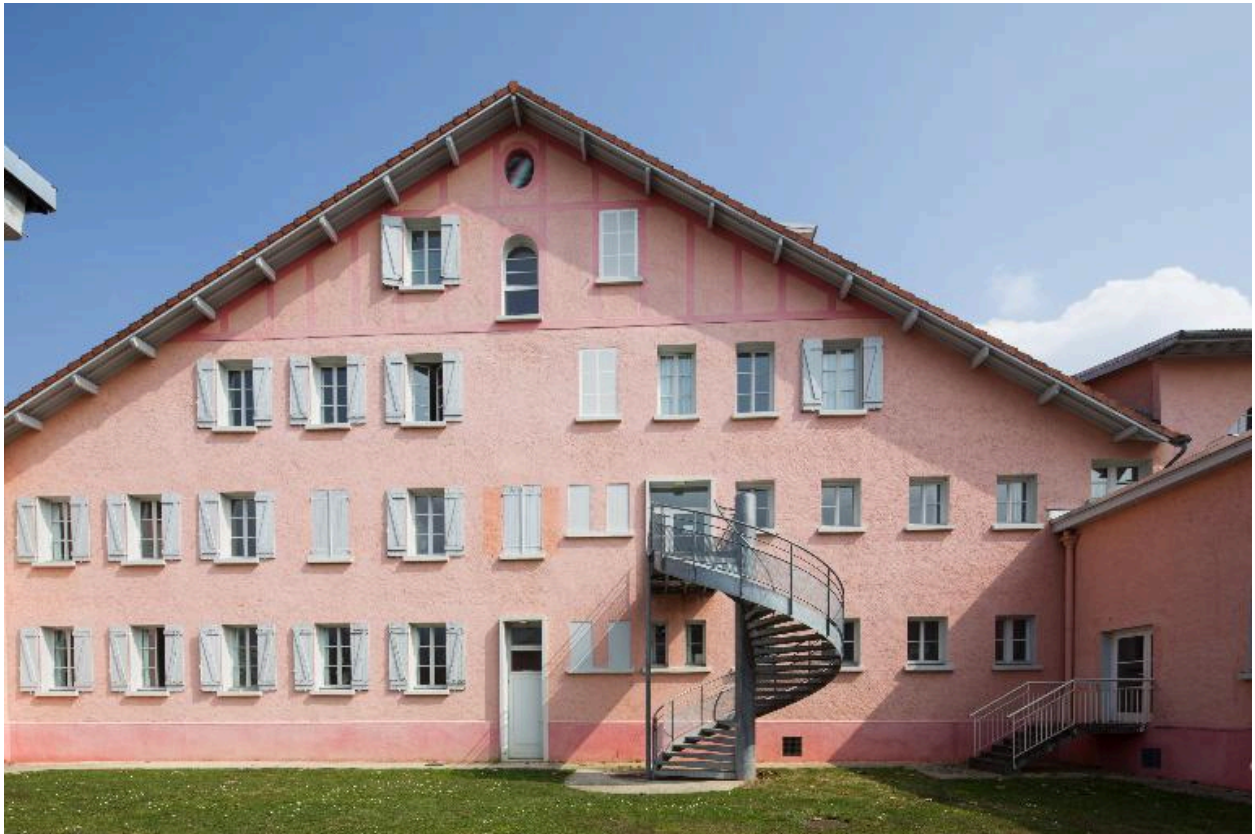
Bât. A : façade nord-ouest de l'aile est
