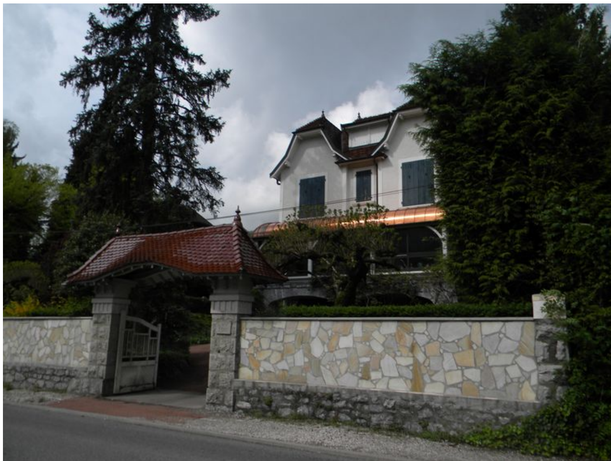
Vue depuis la route avec le porche d'entrée.
