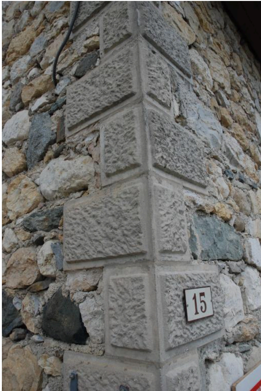
Détail d'une chaîne d'angle en béton moulé
