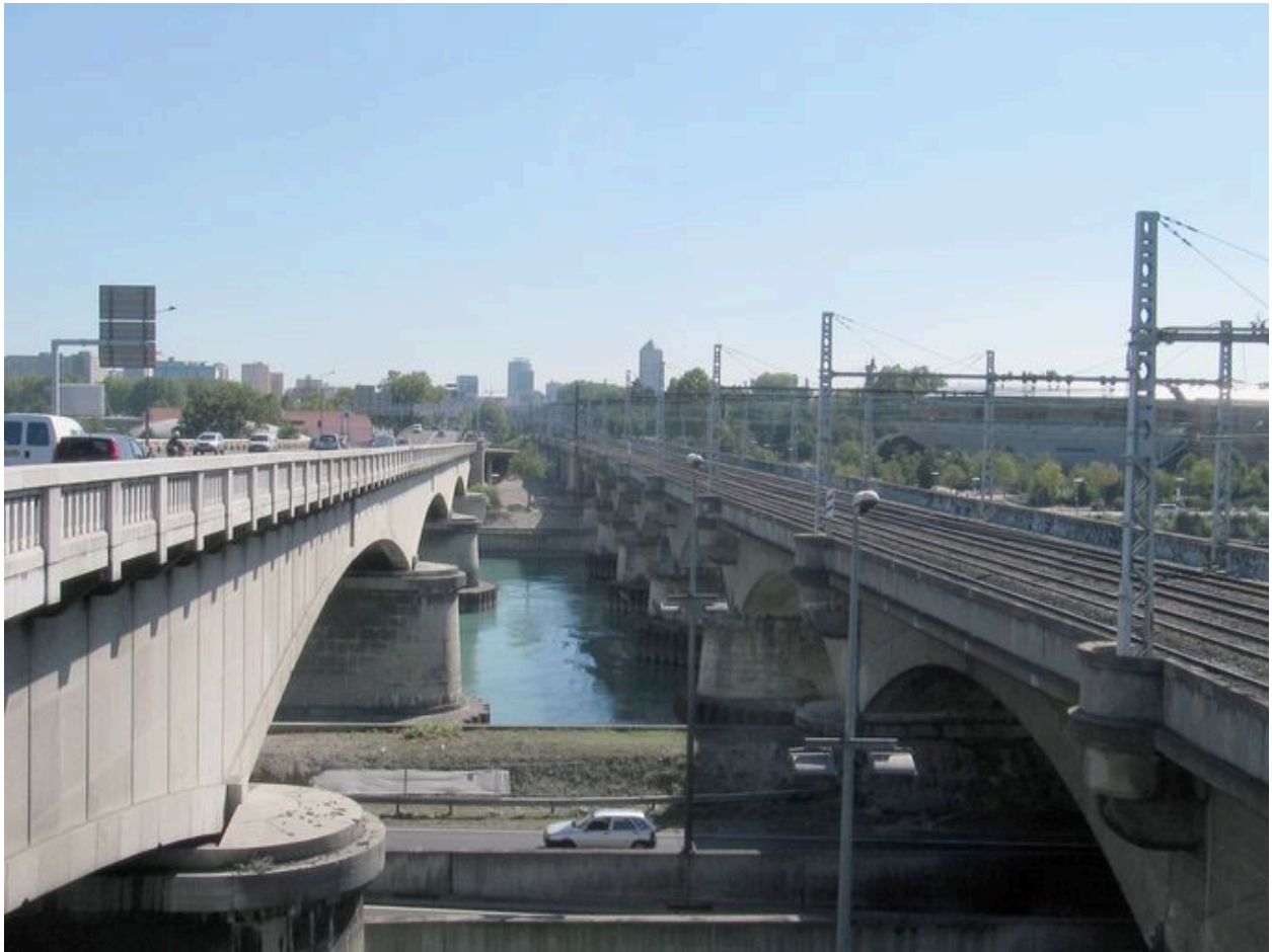
Vue générale, de dessus, face aval (depuis la rive droite) ; le viaduc ferroviaire sur la droite
