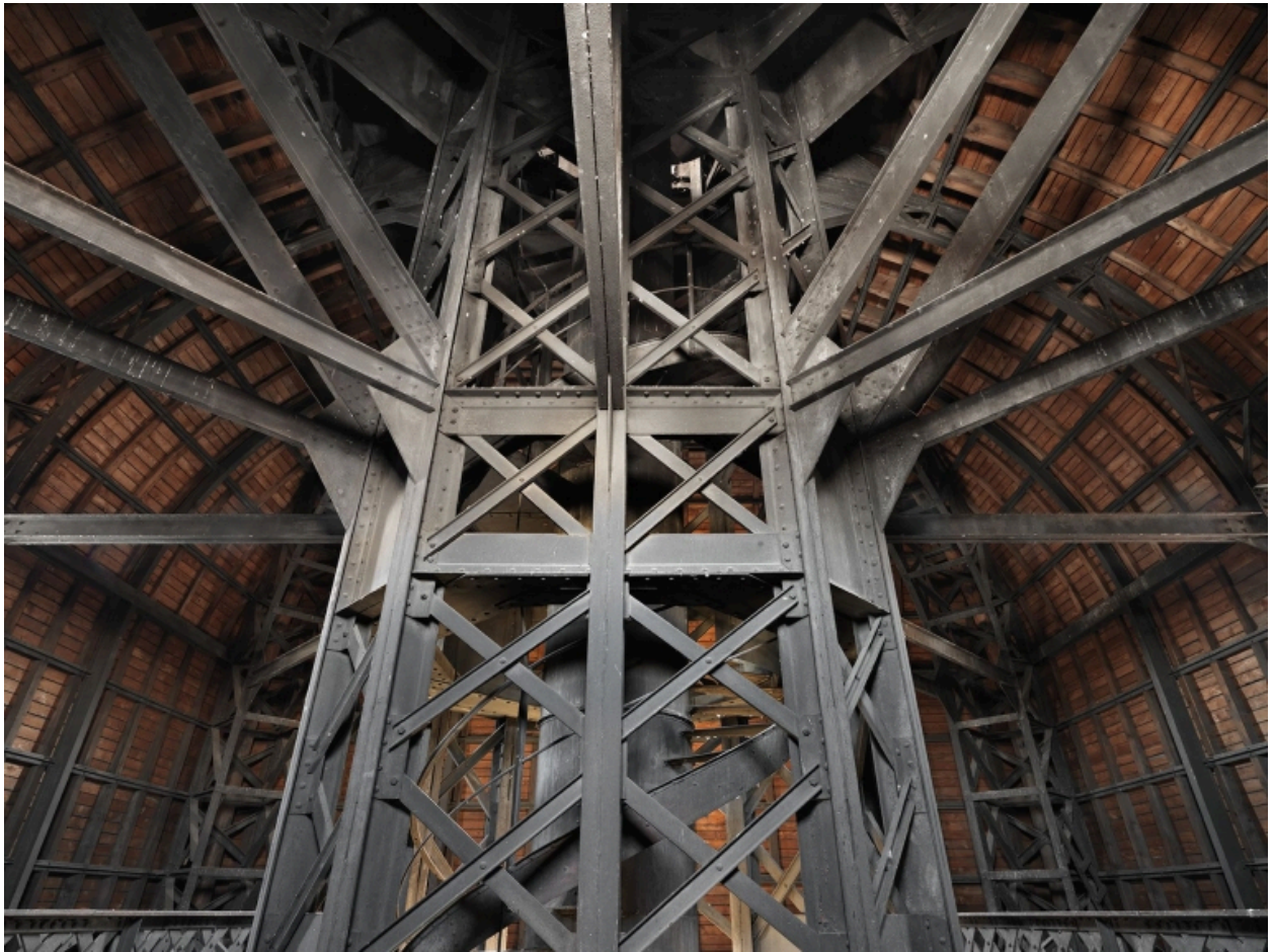
Le dôme Pascalon. 2e étage. La cage d'escalier
