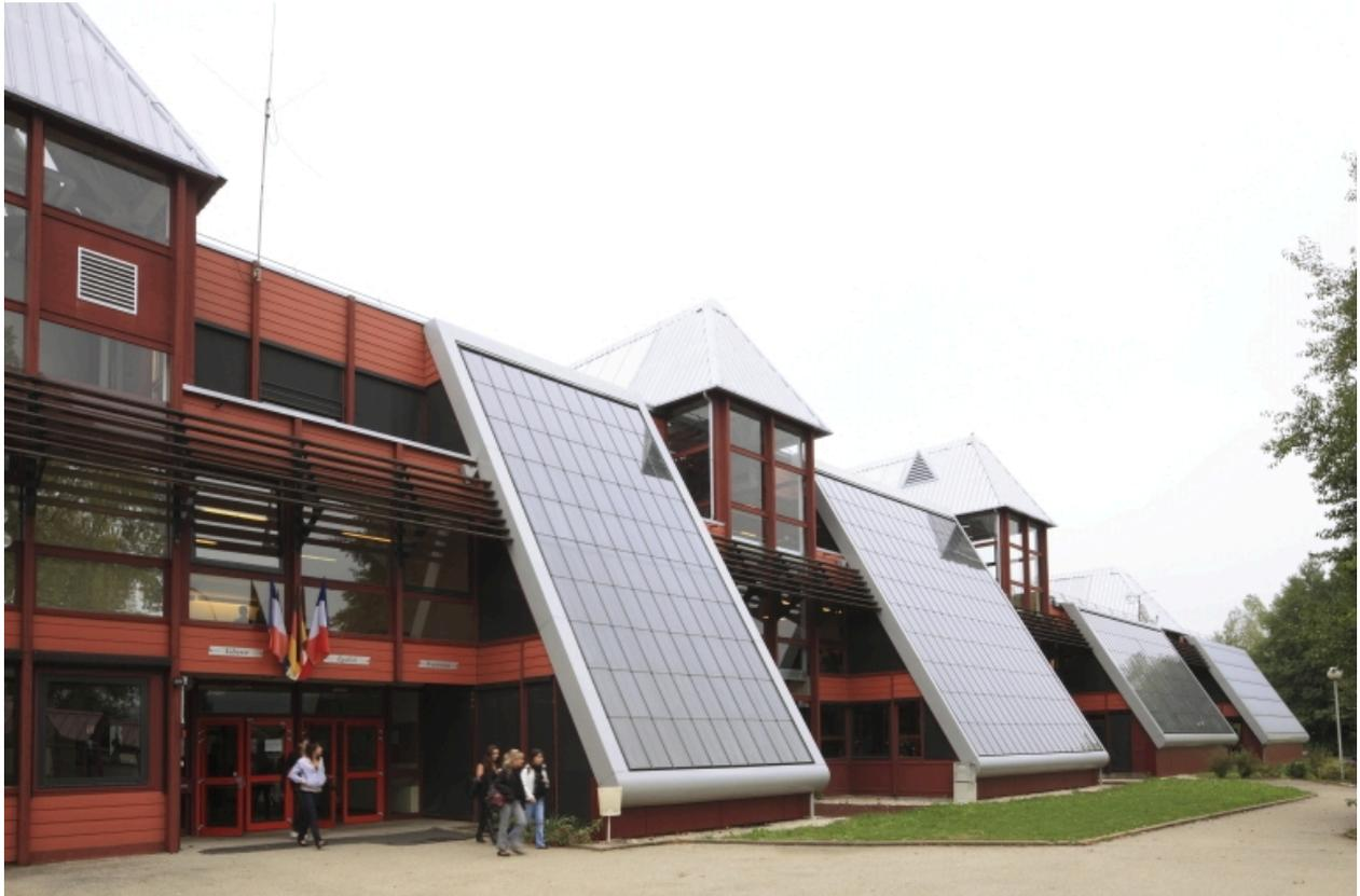
Bâtiment A, façade sud extérieure. Les panneaux solaires sur plans inclinés à 60°, après les travaux de réhabilitation. On remarquera les brise-soleil au-dessus de l'entrée du lycée, à gauche.
