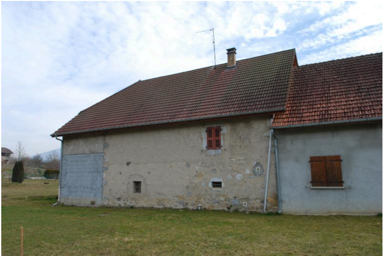
Vue arrière partielle de la ferme.
