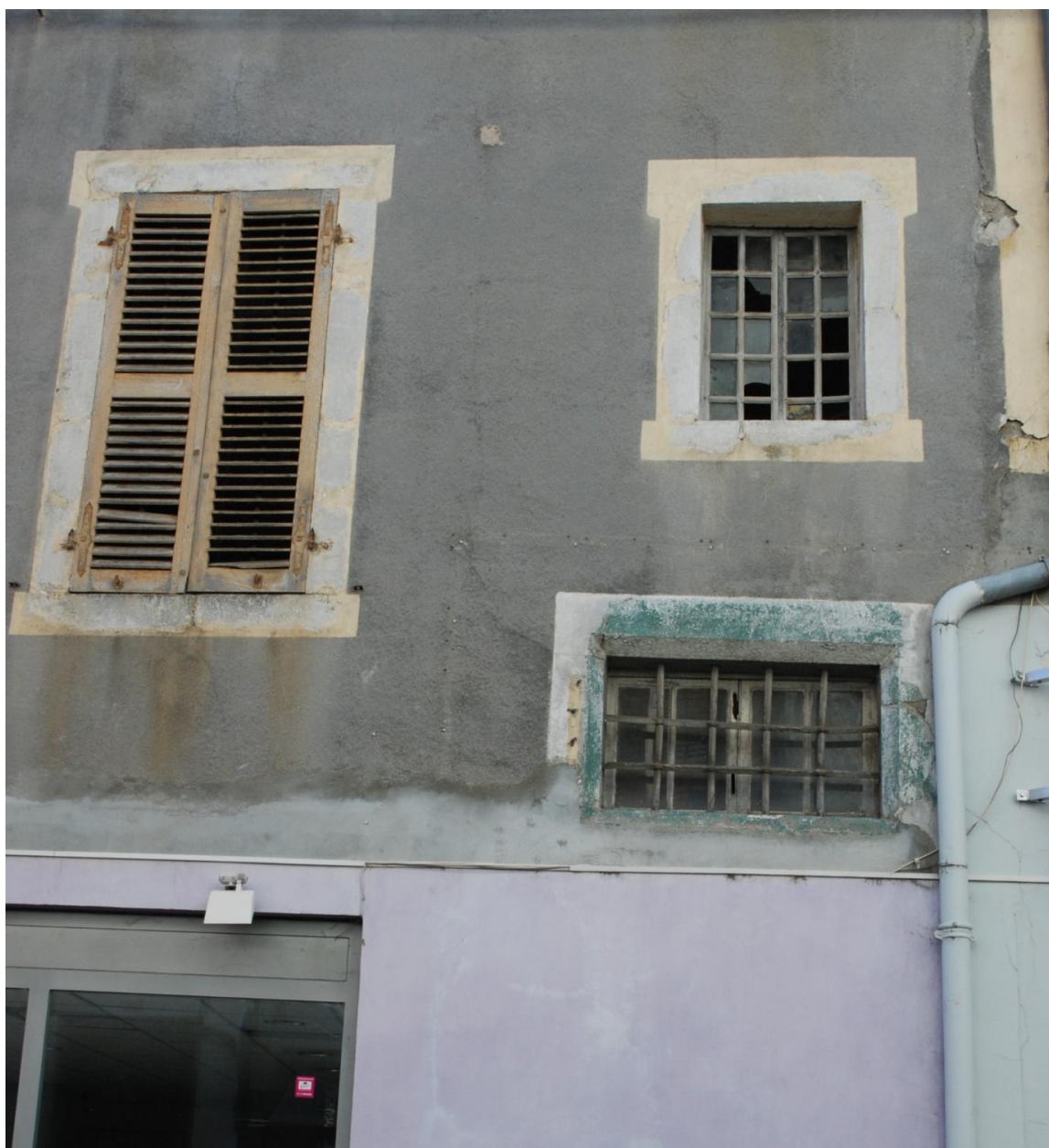
Détail de la façade du n° 57 rue Louis Blanc-Pinget (2018 E1 288), porte murée correspondant au n°50 (2018 E1 283).
