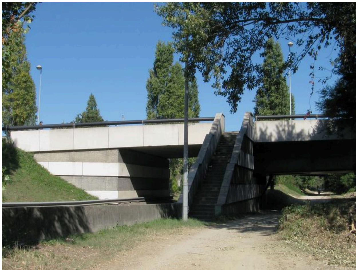
Travée de rive gauche, face amont
