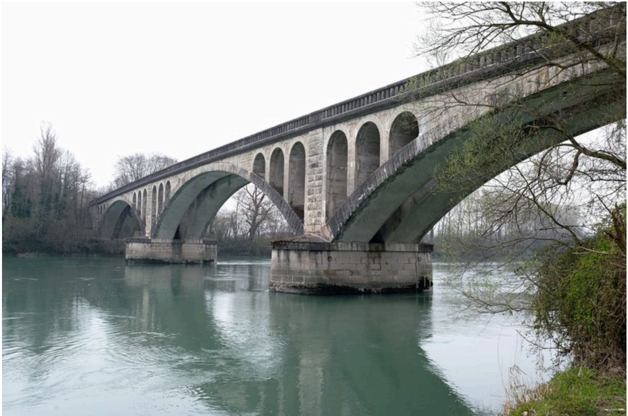
Vue côté amont, depuis la rive droite
