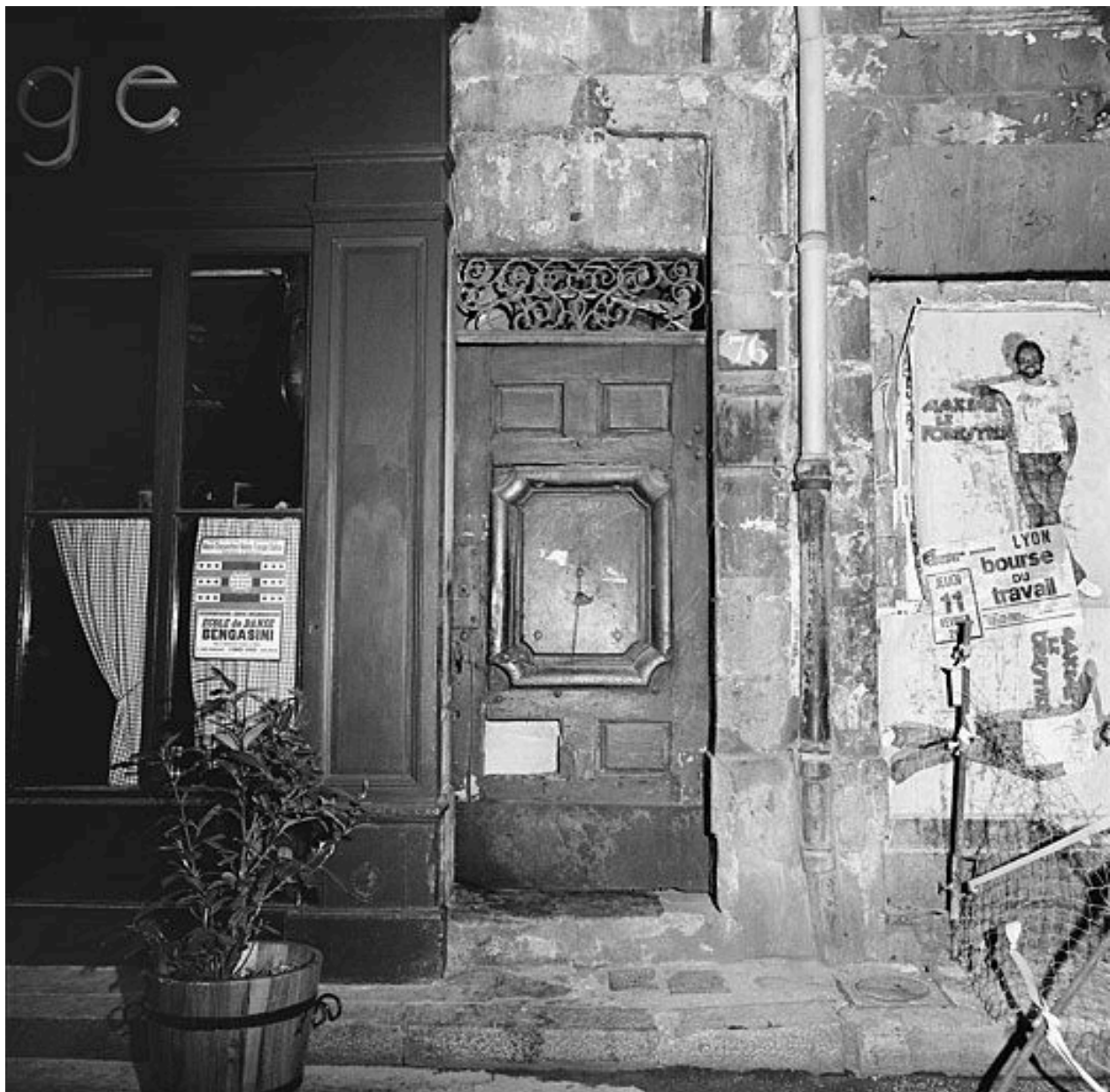
Détail de la porte piétonne
