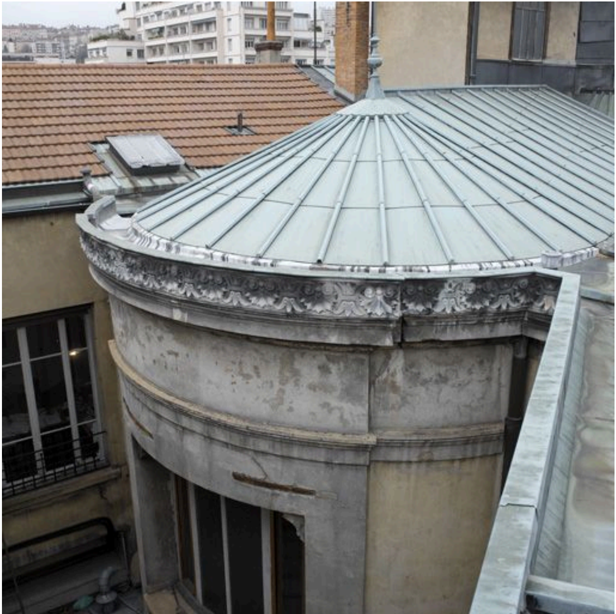
La couverture de la cage d'escalier hors-oeuvre depuis la toiture de l'aile Guimet
